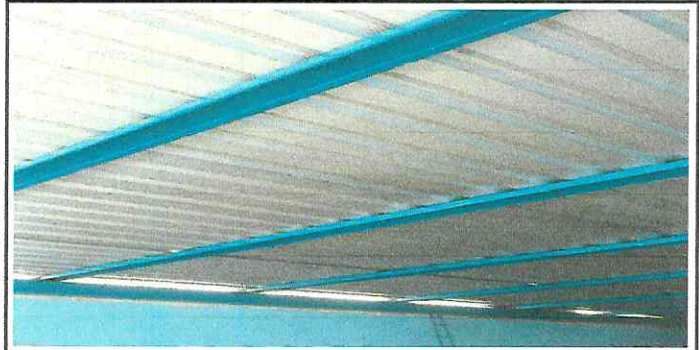
Foto 2: ya instalada la lámina y las costaneras
