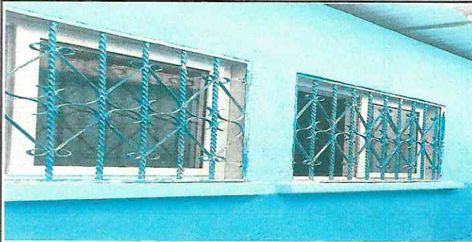
Foto 3: Balcones instalados en las ventanas
