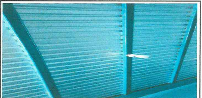
Foto 6: Techo en perfectas condiciones
